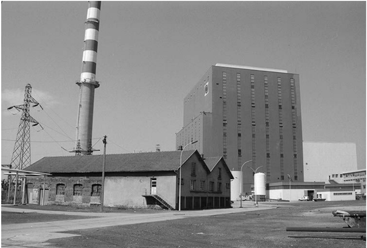
Vestiges de l'ancienne cartonnerie de Lucy vus du sud (à l'arrière, Lucy III).
