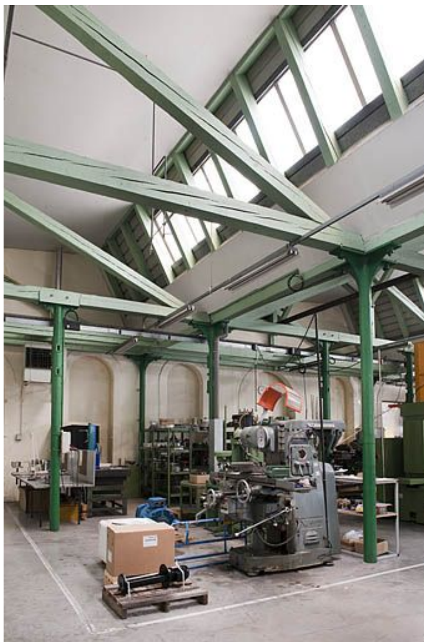
Atelier d'outillage. Détail de la charpente.
