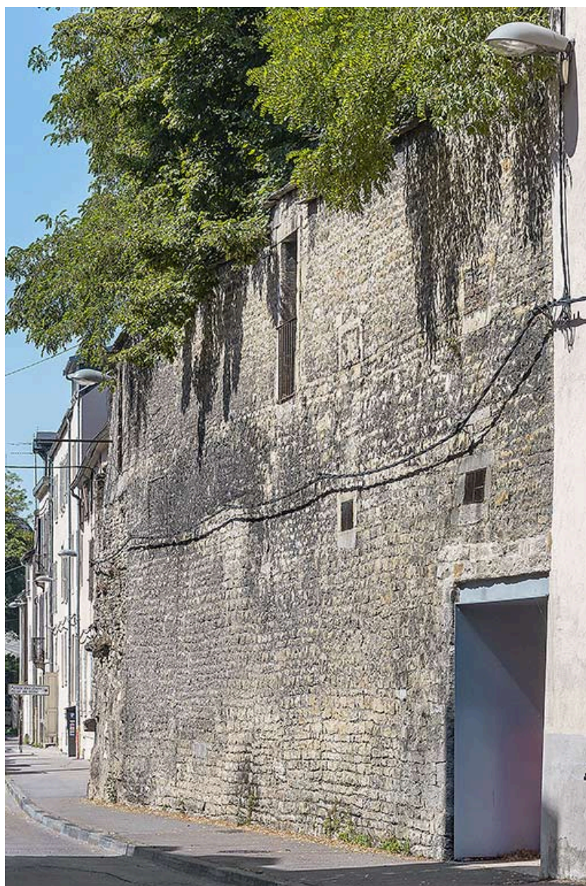
Détail de la maçonnerie du rempart, rue Berlier.
