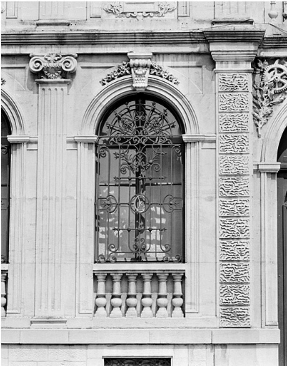
Banque. Façade principale, fenêtre du rez-de-chaussée.
