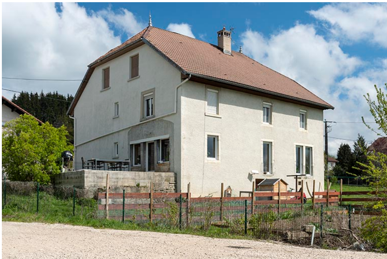
Façades postérieure et latérale droite.
