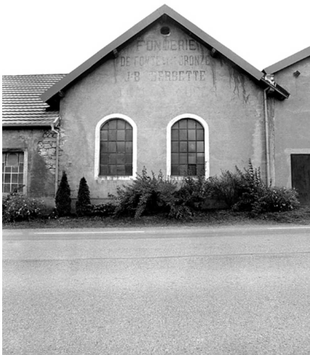
Mur-pignon d'un atelier de fabrication.
