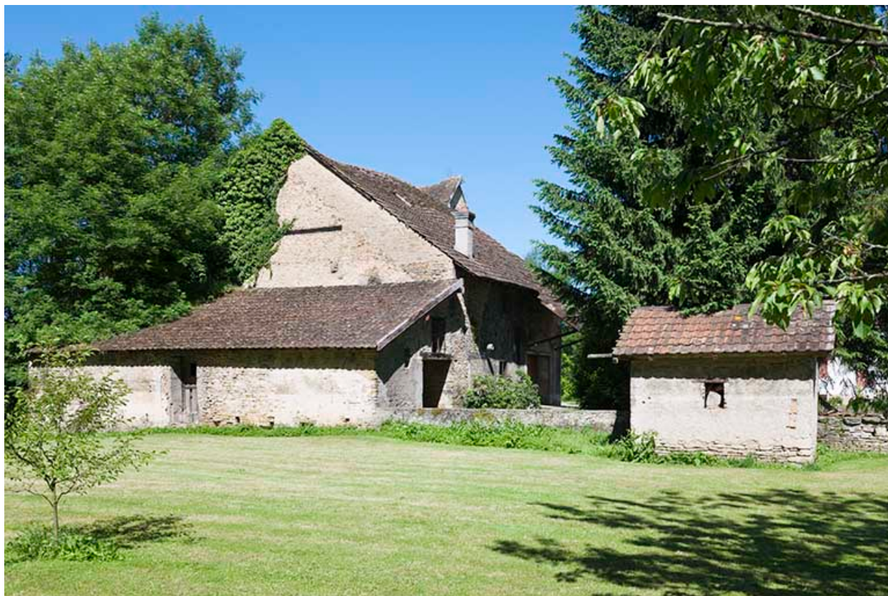
Dépendance vue depuis l'est.
