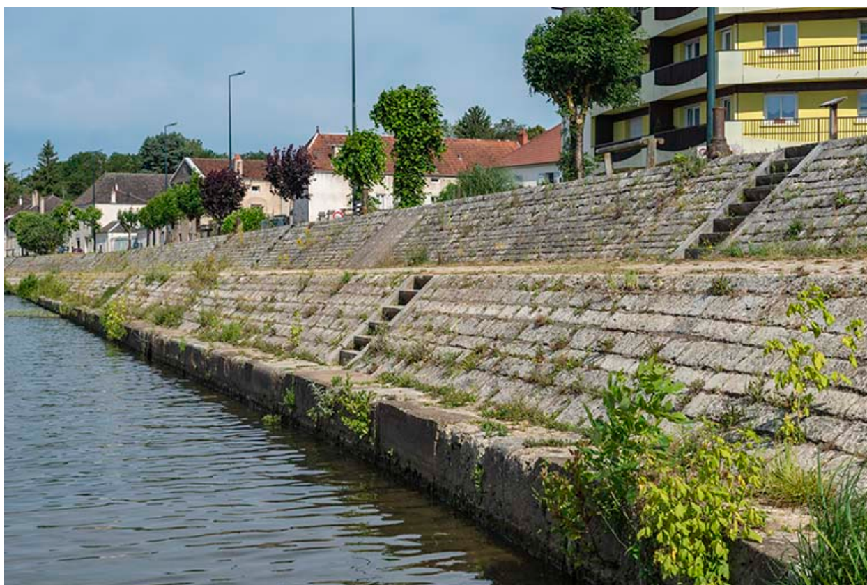
Prologement du quai Villeneuve.
