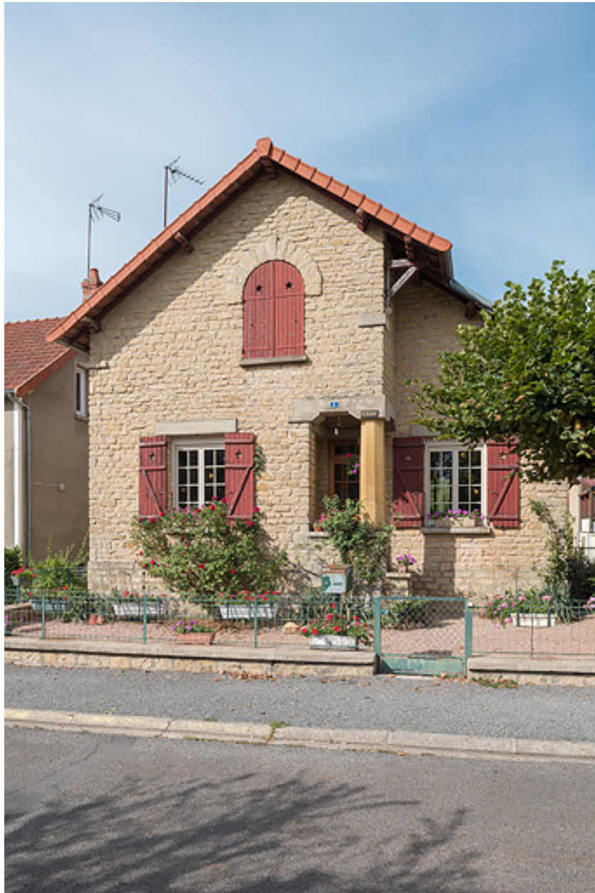
Façade sur l'avenue Claude Dellys.
