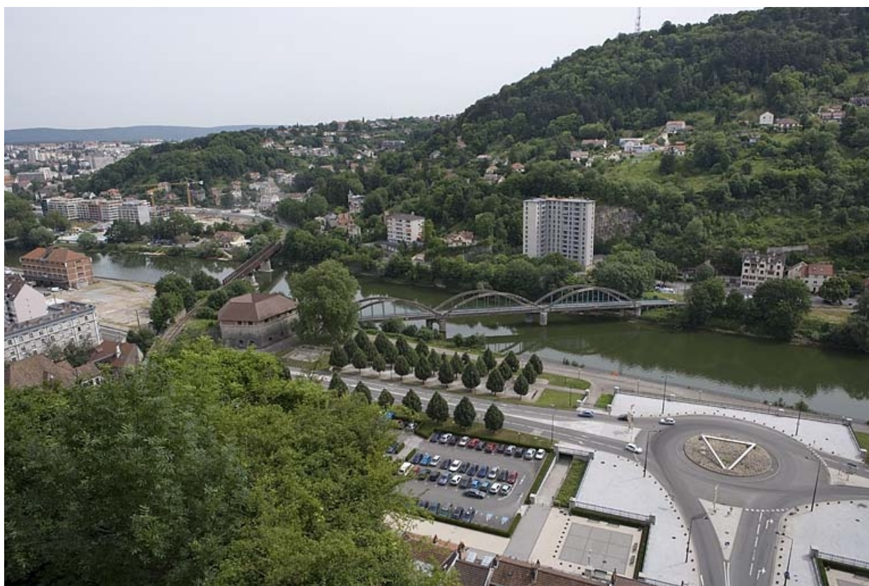
Vue d'ensemble plongeante sur la partie nord.
