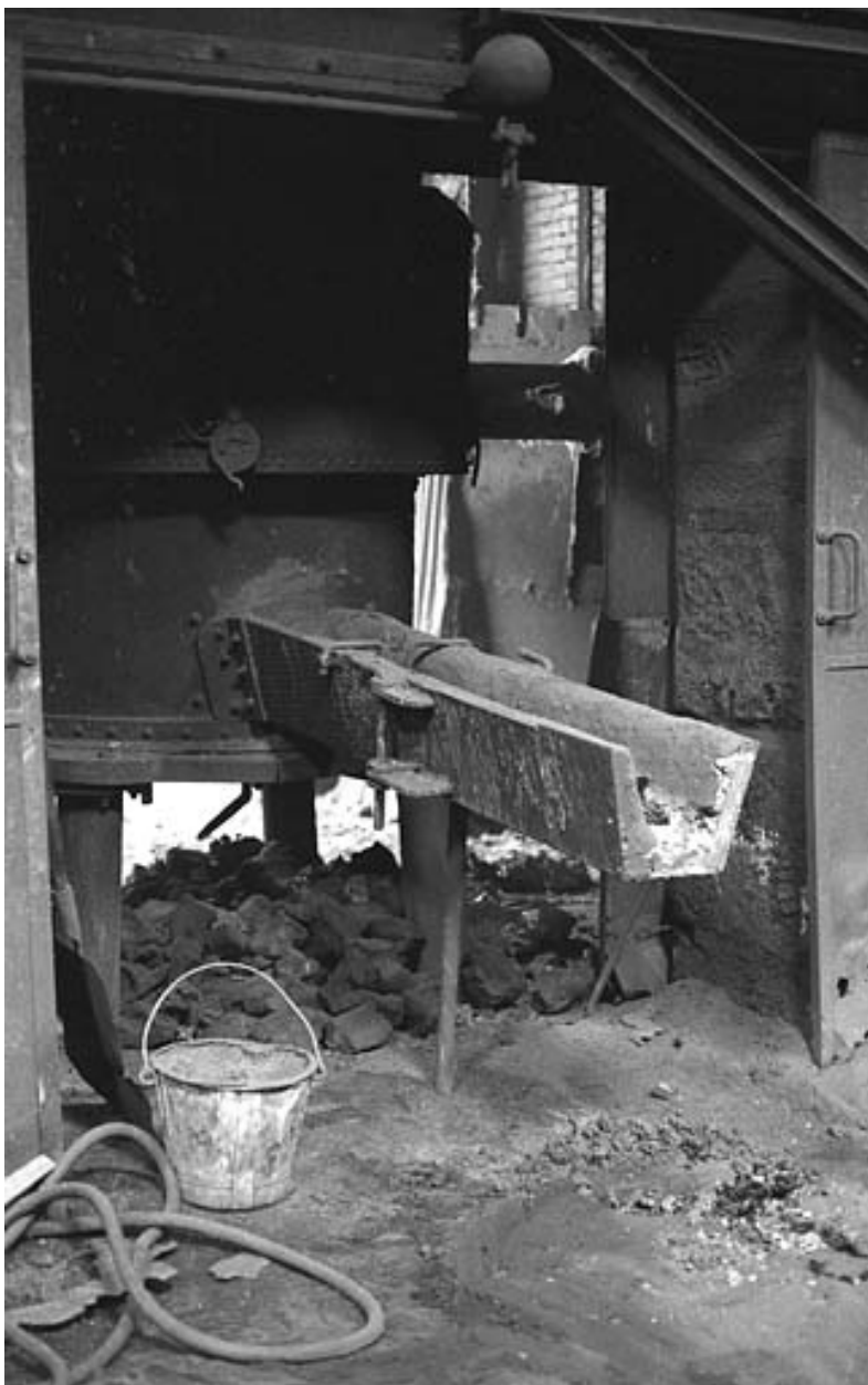
Grand cubilot. Rigole de coulée.
