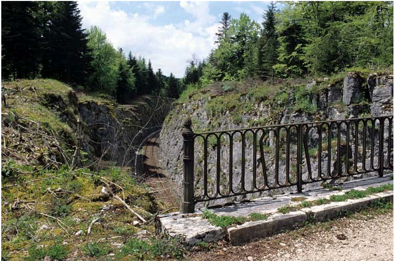
Tranchée côté Andelot-en-Montagne et détail du garde-corps.
