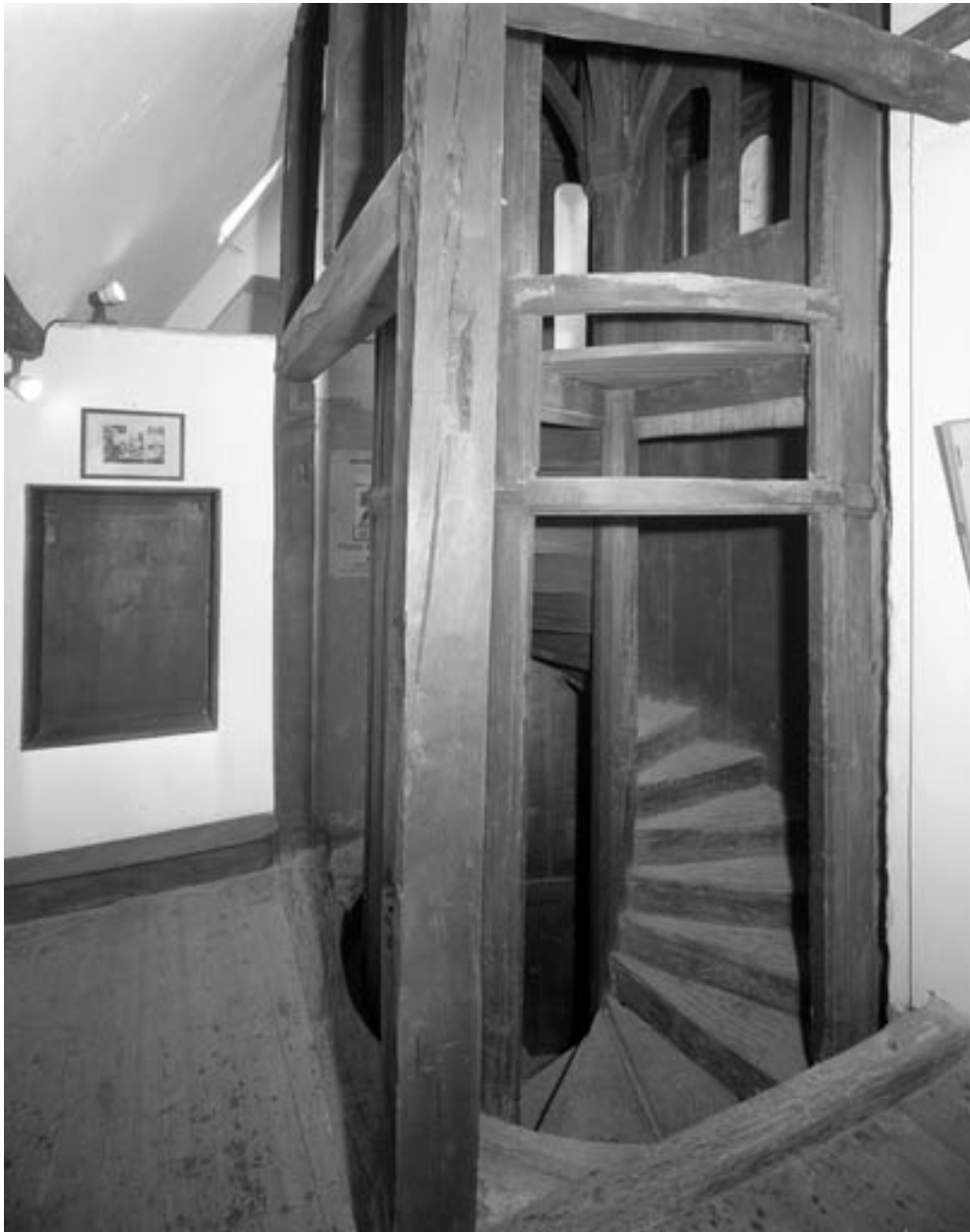
Détail du cylindre pivotant ouvert, au niveau de la cellule de saint Pierre Fourier.
