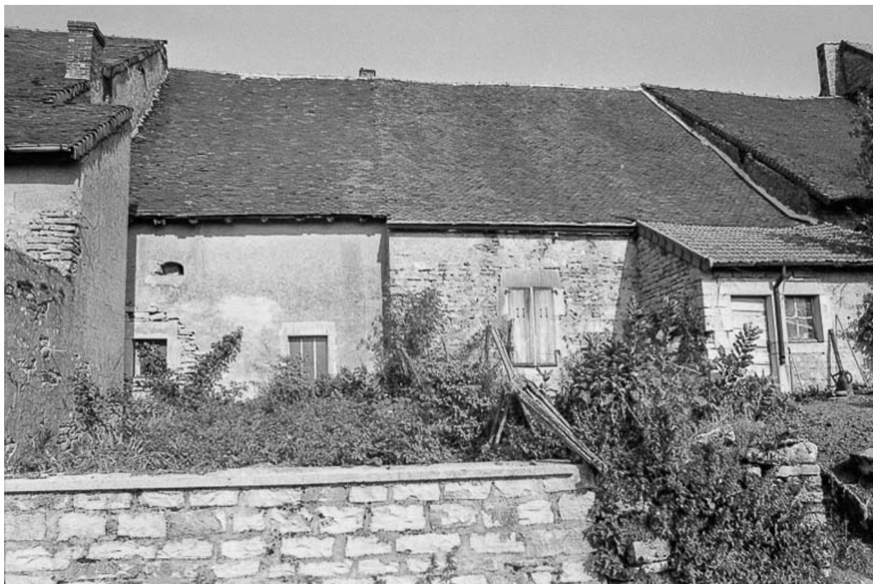
Fermes cadastrées D2 293 et 294 : façades postérieures.
