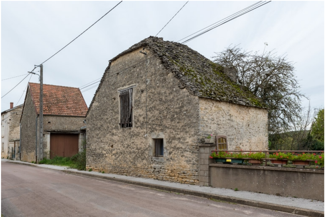
Vue d'ensemble depuis sud-est.
