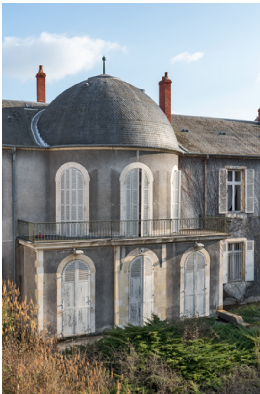
Façade sur le jardin, avant-corps.
