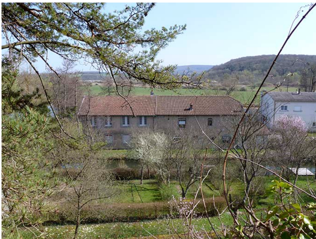
Vue générale des deux bâtiments, depuis l'ouest.
