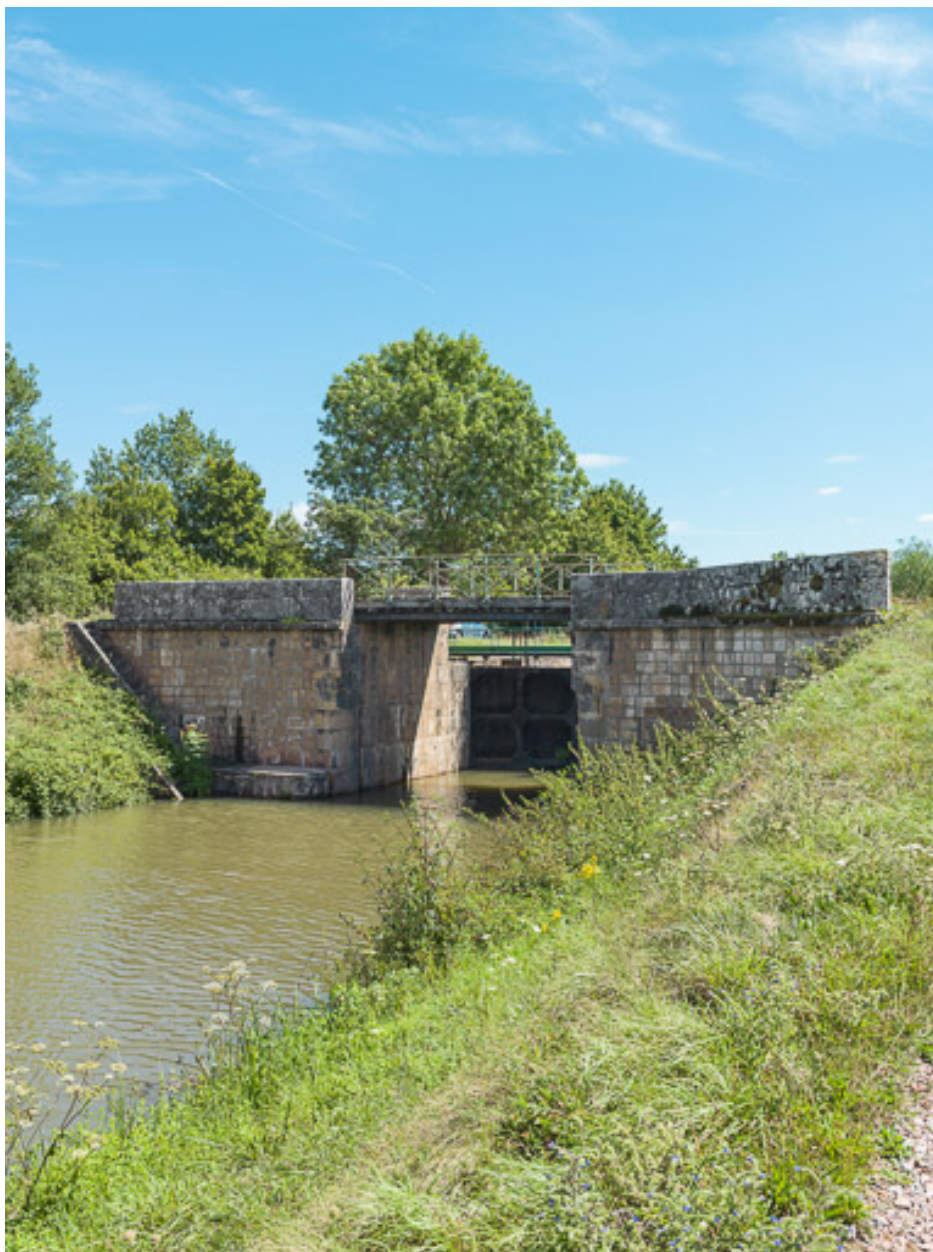
Vue d'ensemble du pont.
