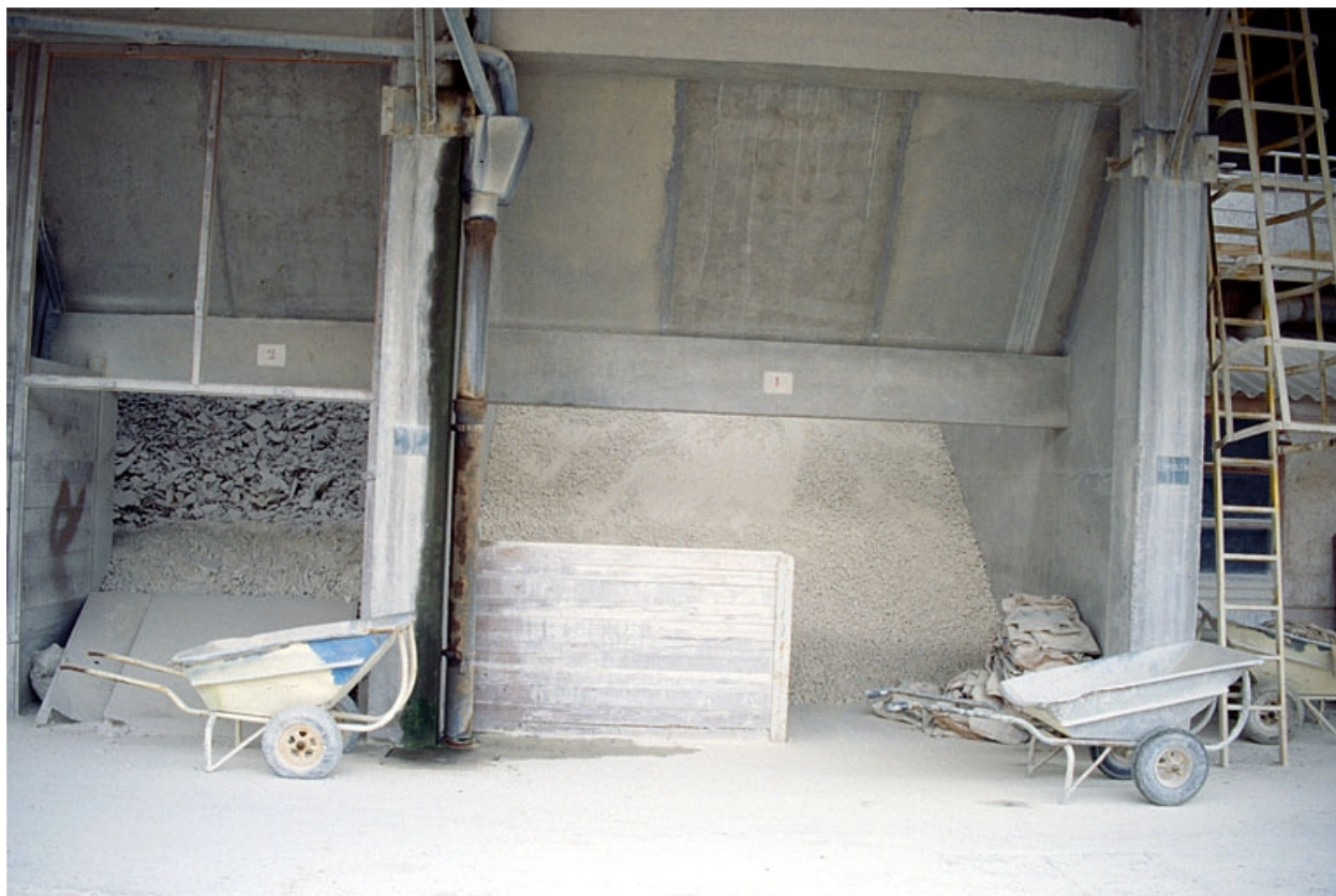
Hangar à terre (18) : détail des silos ouverts.
