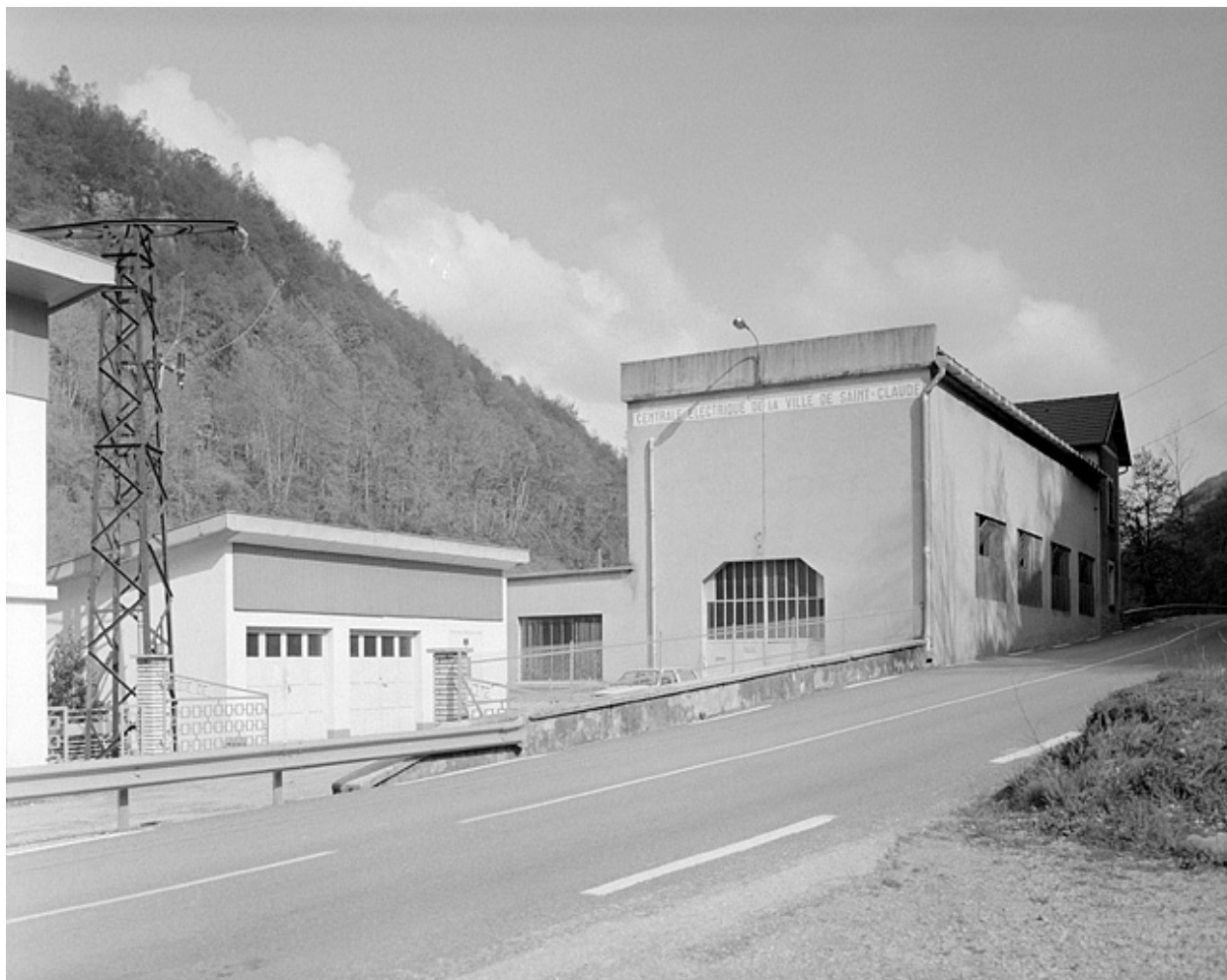
Façade antérieure de la centrale.
