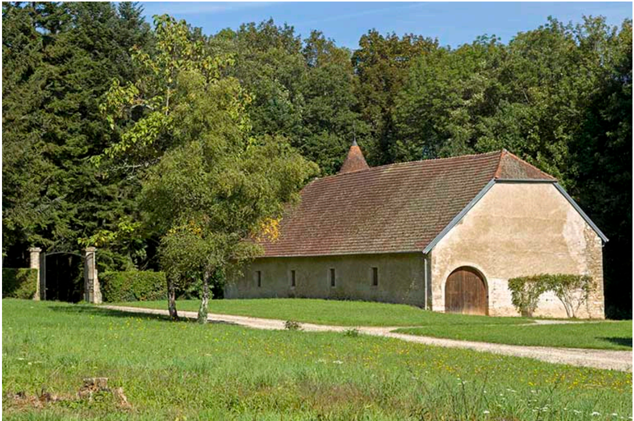
Vue générale du cuvage.
