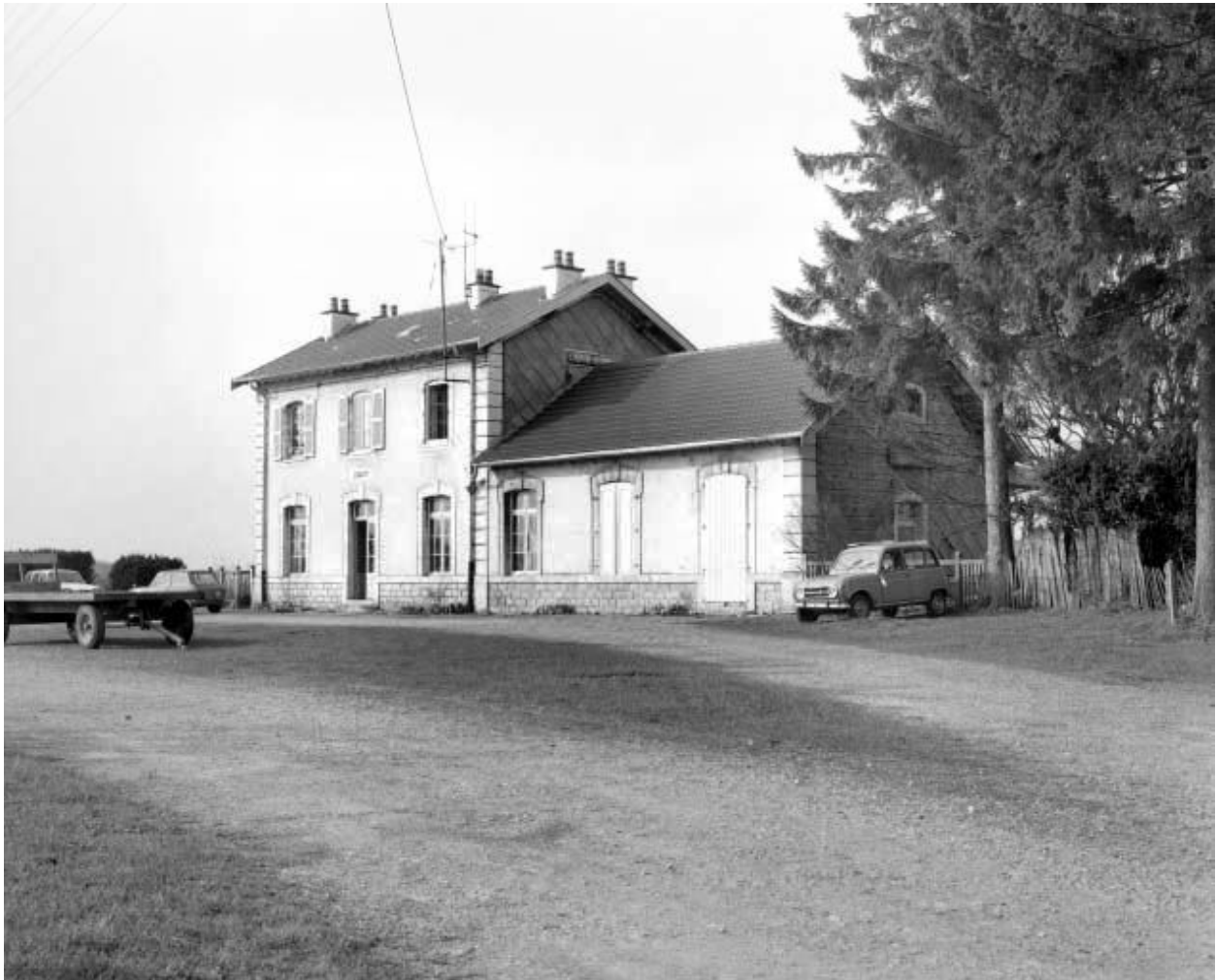
L'Hôpital-du-Grosbois : façade antérieure de la gare de voyageurs.
