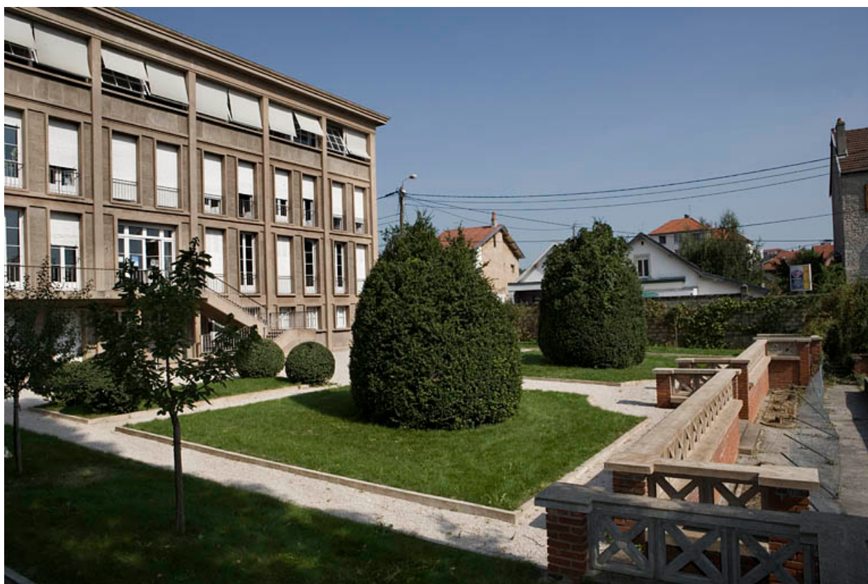
Jardin et face latérale gauche de l'usine.
