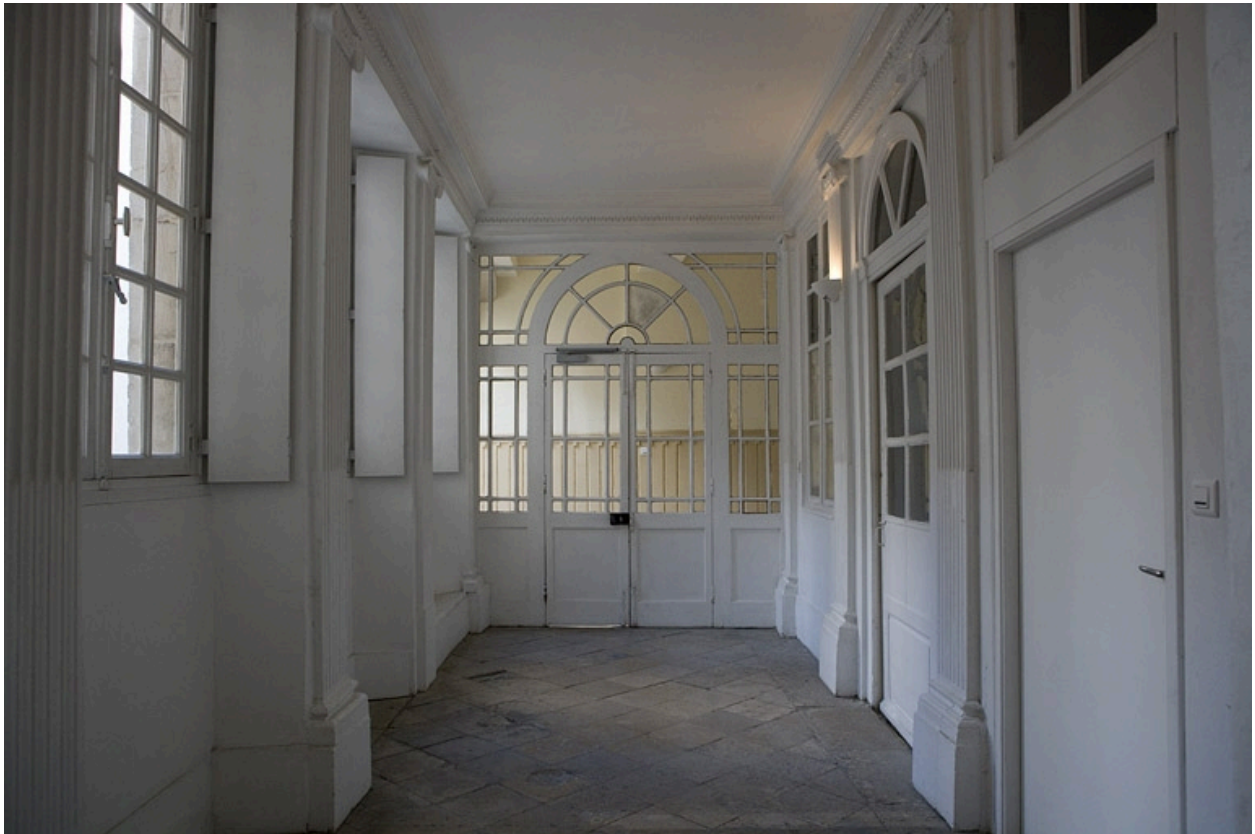
Vue d'ensemble du vestibule.
