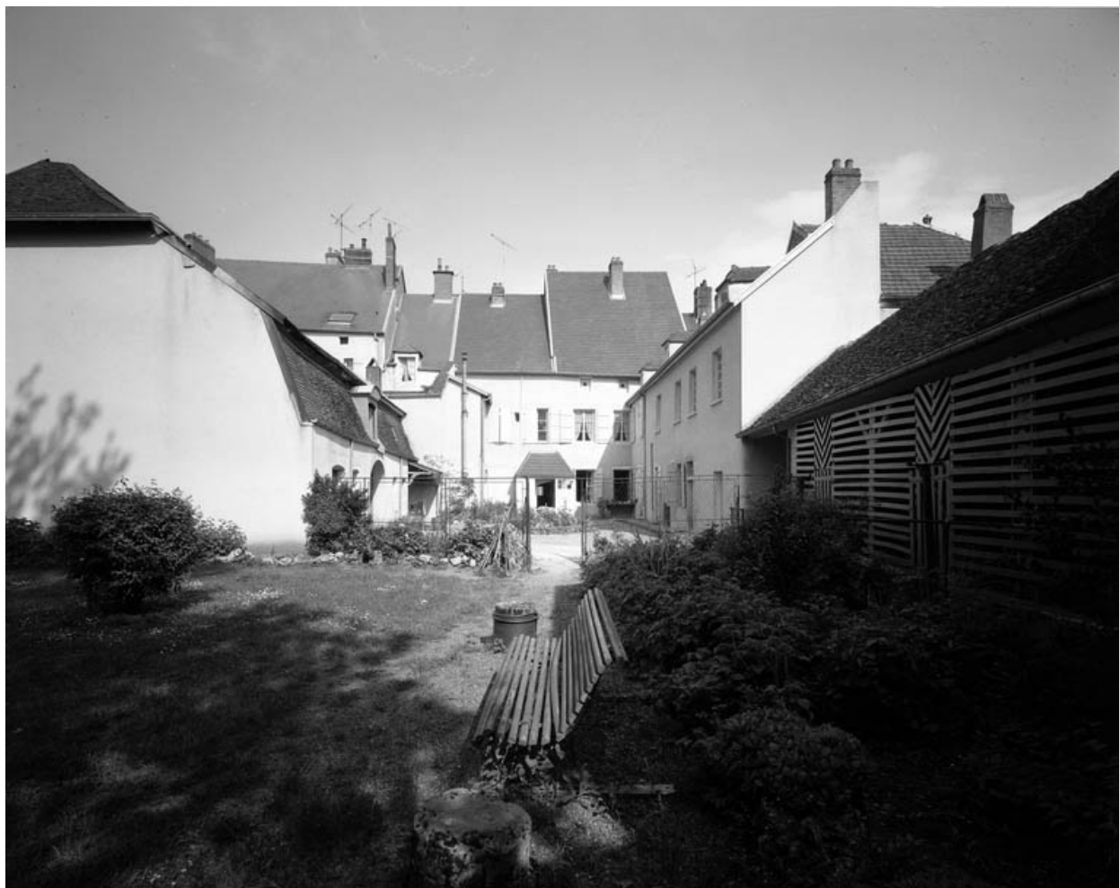
Façades sur cour.
