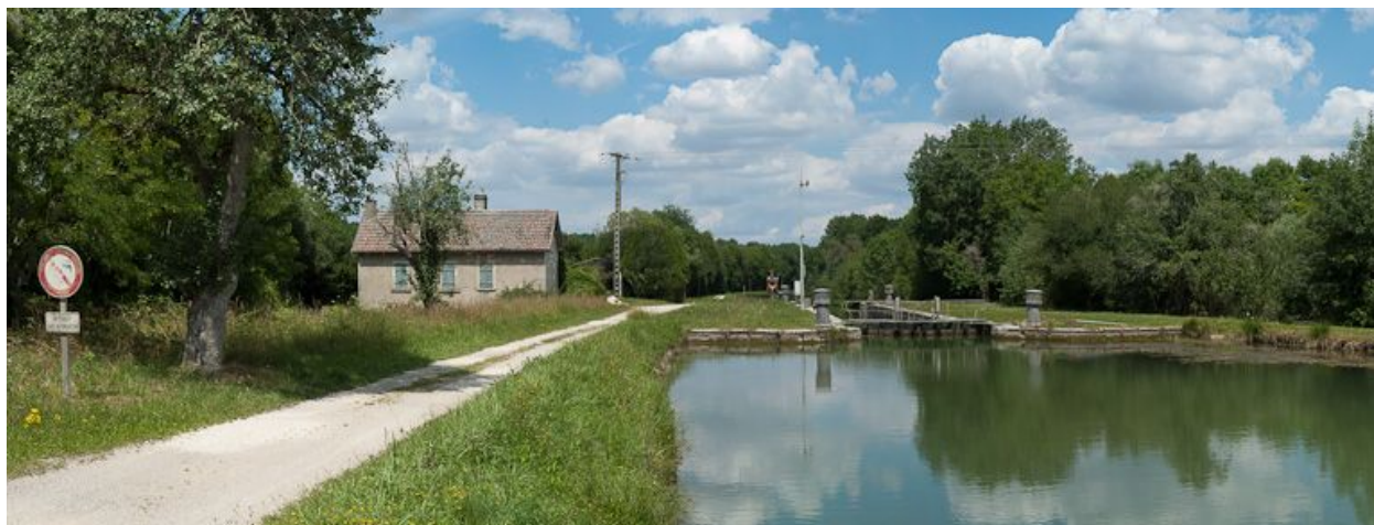
Vue du site d'écluse depuis l'amont.
