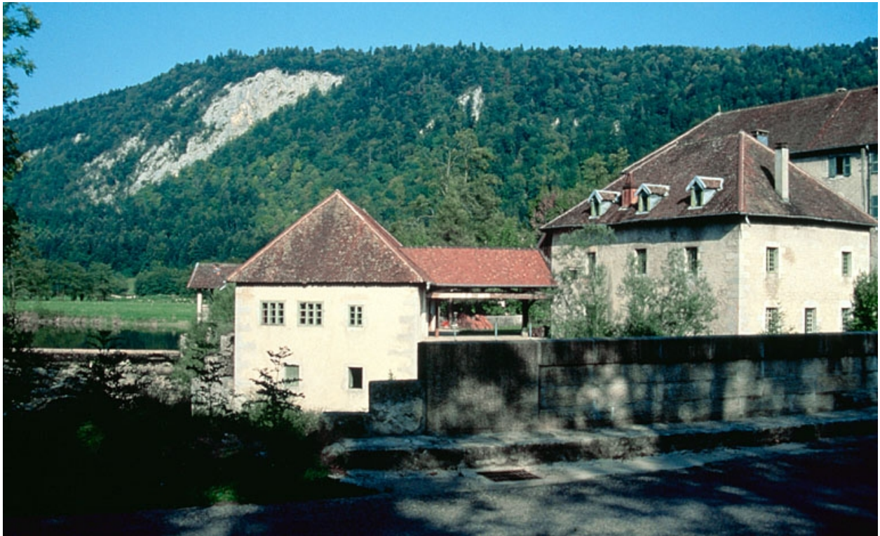
Vue d'ensemble depuis le pont, à l'ouest.
