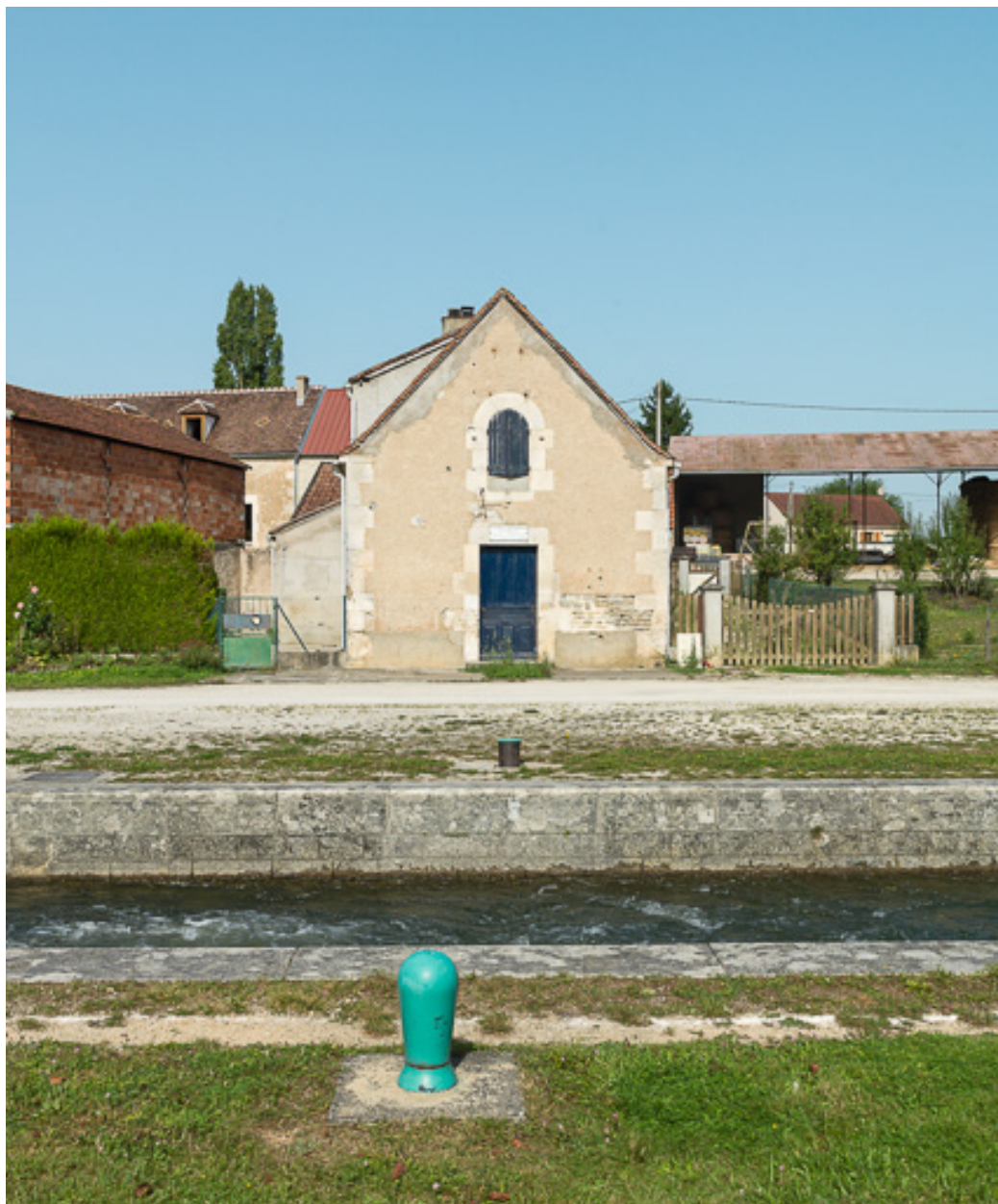
Vue de la maison éclusière.
