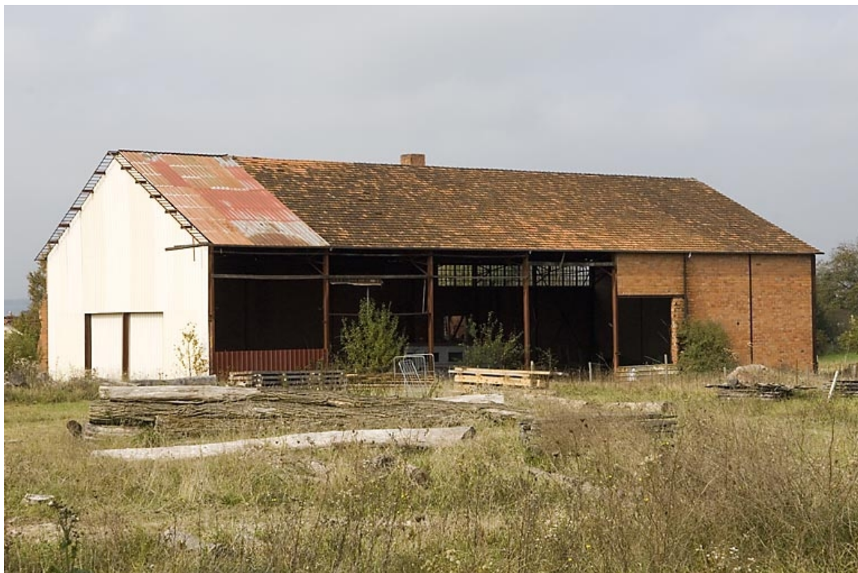
Atelier de fabrication depuis le sud-est.
