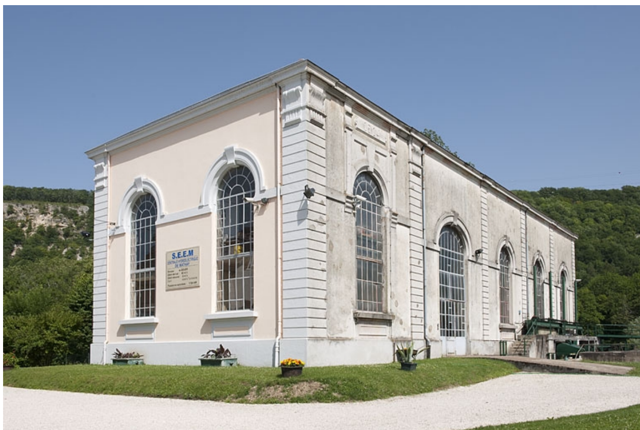
Centrale vue de trois quarts, depuis l'entrée.
