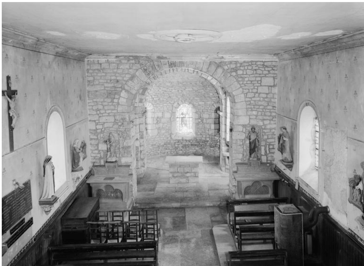
Vue d'ensemble depuis la tribune.
