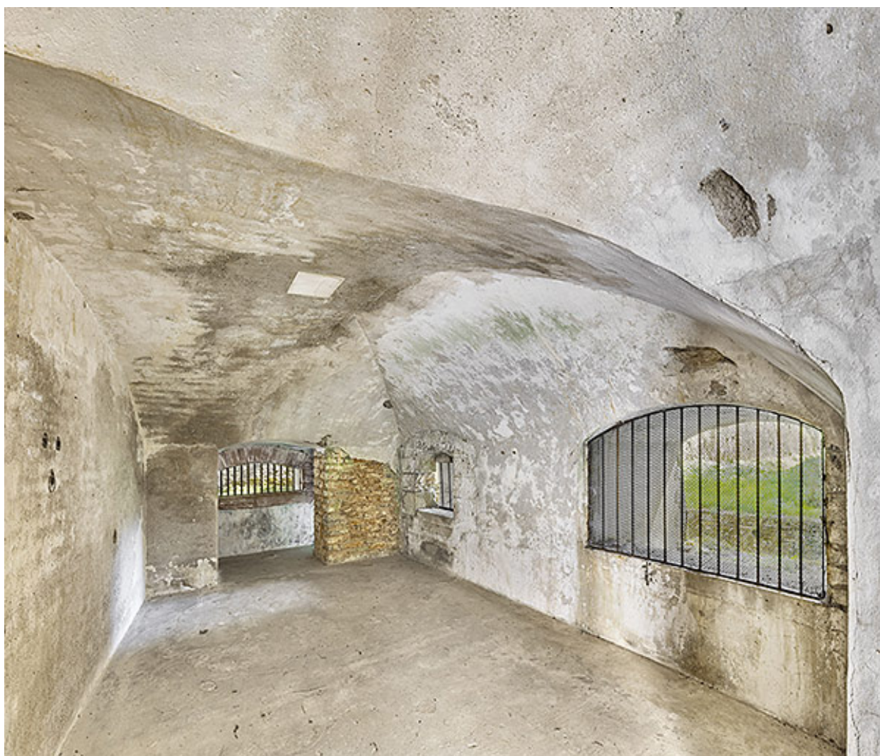
Vue intérieure de la double caponnière.
