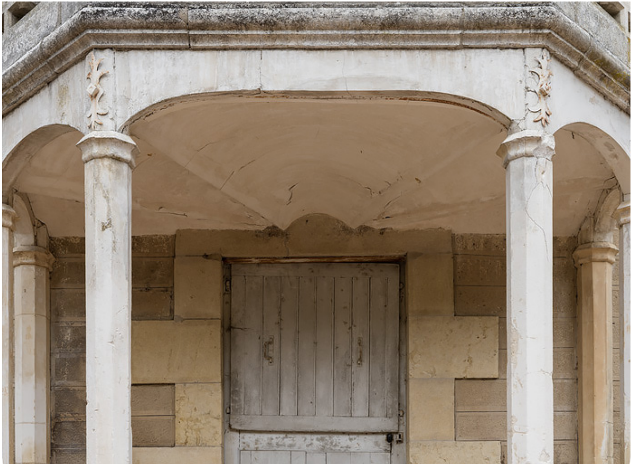
Balcon du rez-de-chaussée surélevé reposant sur une voûte en éventail armée.
