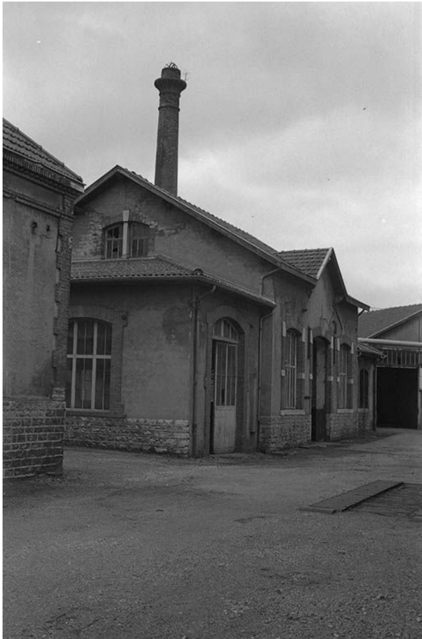
Façade antérieure de l'atelier de montage.
