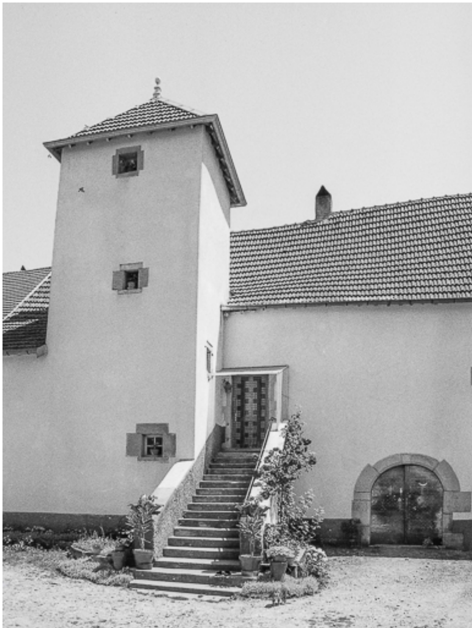
Détail : tour d'escalier et entrée de l'habitation.
