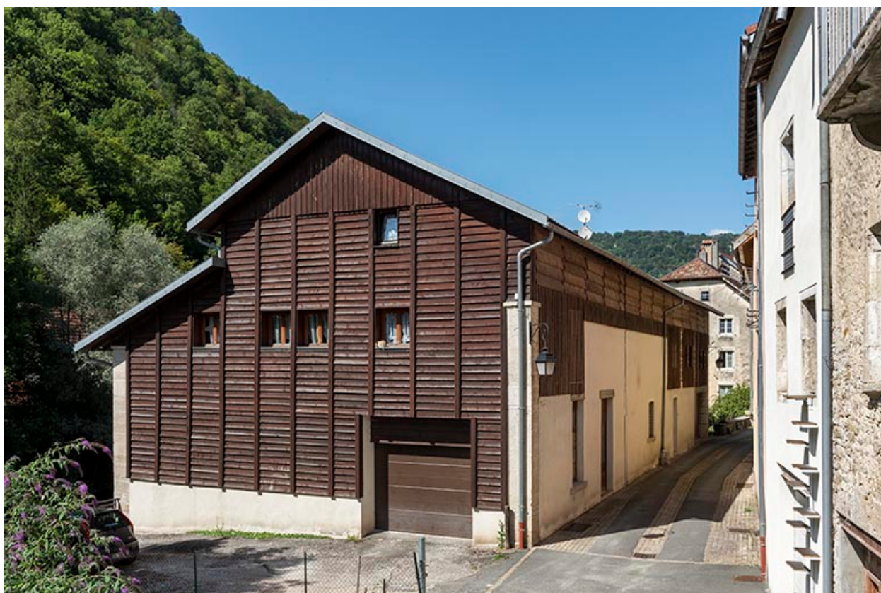
Tannerie : façades postérieure et latérale gauche.
