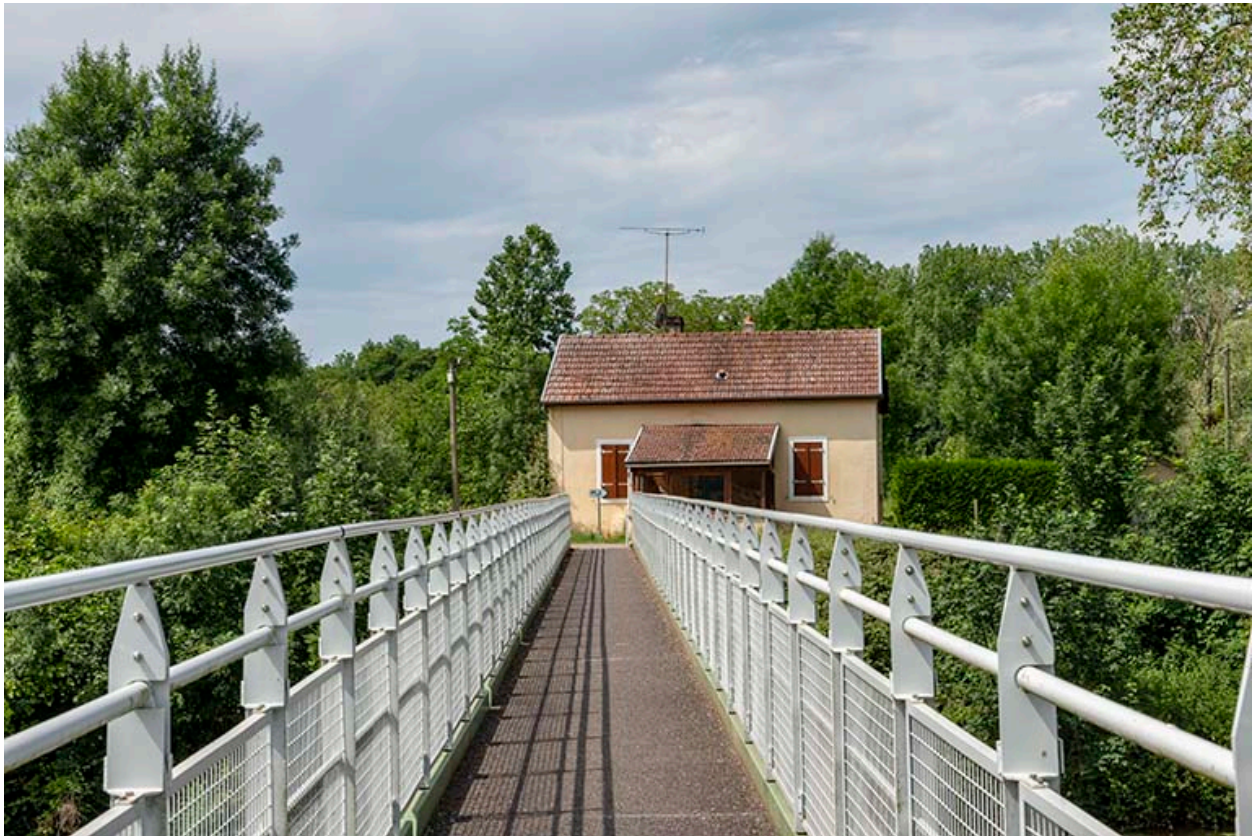
Vue de détail de la passerelle.
