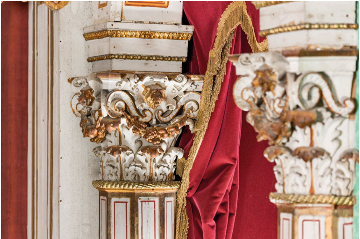
Chapiteaux corinthisants, vus en enfilade (loge d'avant-scène, balcon côté cour).
