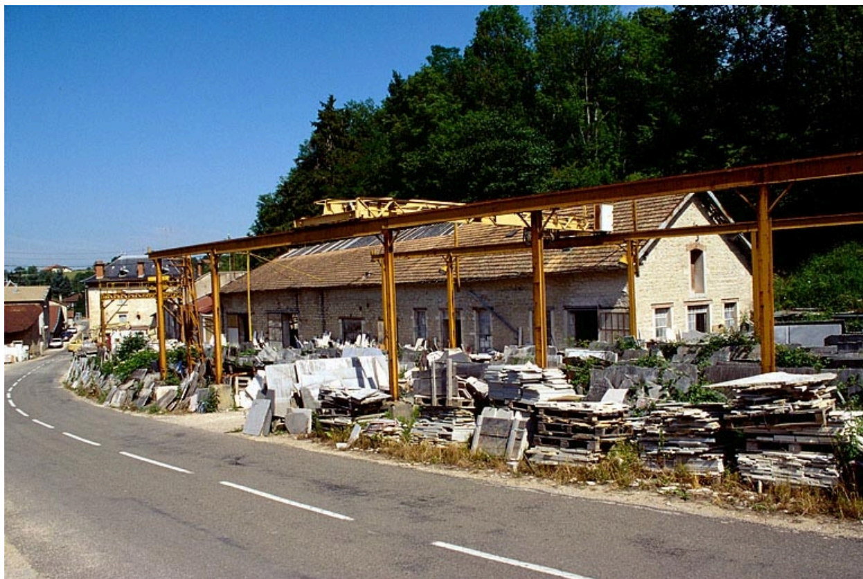
Usine de taille de matériaux de construction Yelmini Artaud, à Balanod : atelier de fabrication, de trois quarts droite.
