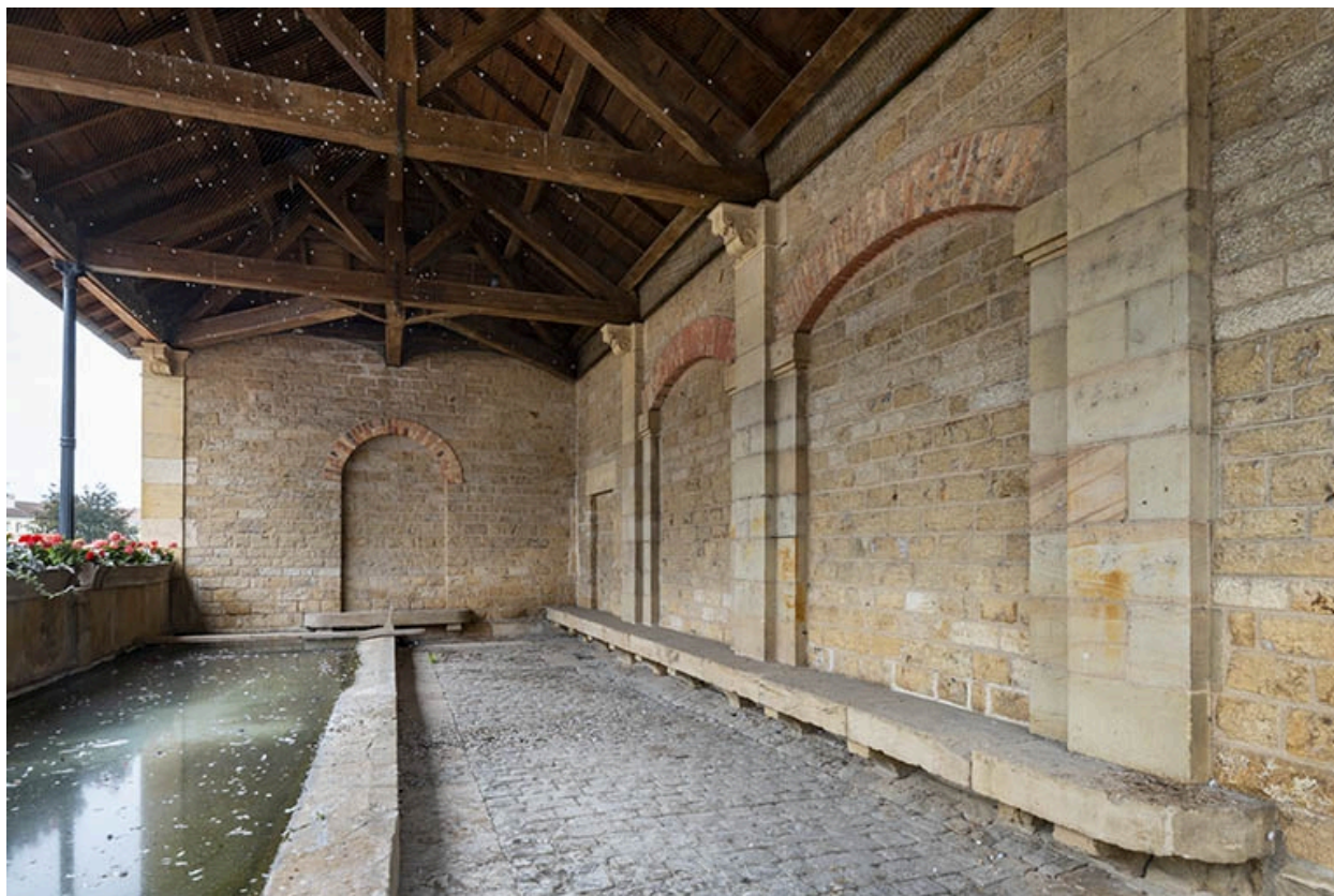
L'intérieur du lavoir en biais, depuis l'entrée.
