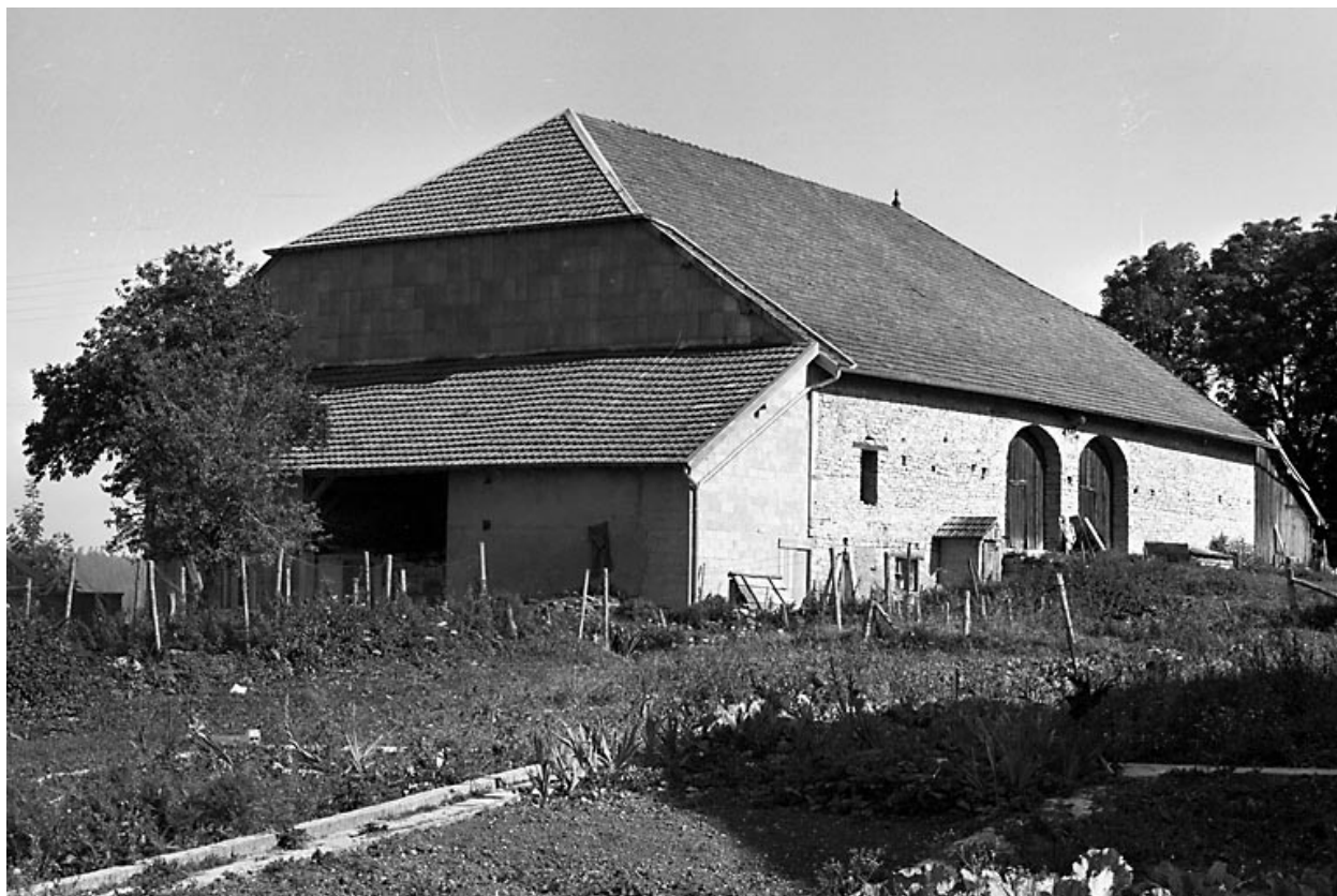
Ferme située rue de l'Eglise : vue d'ensemble.
