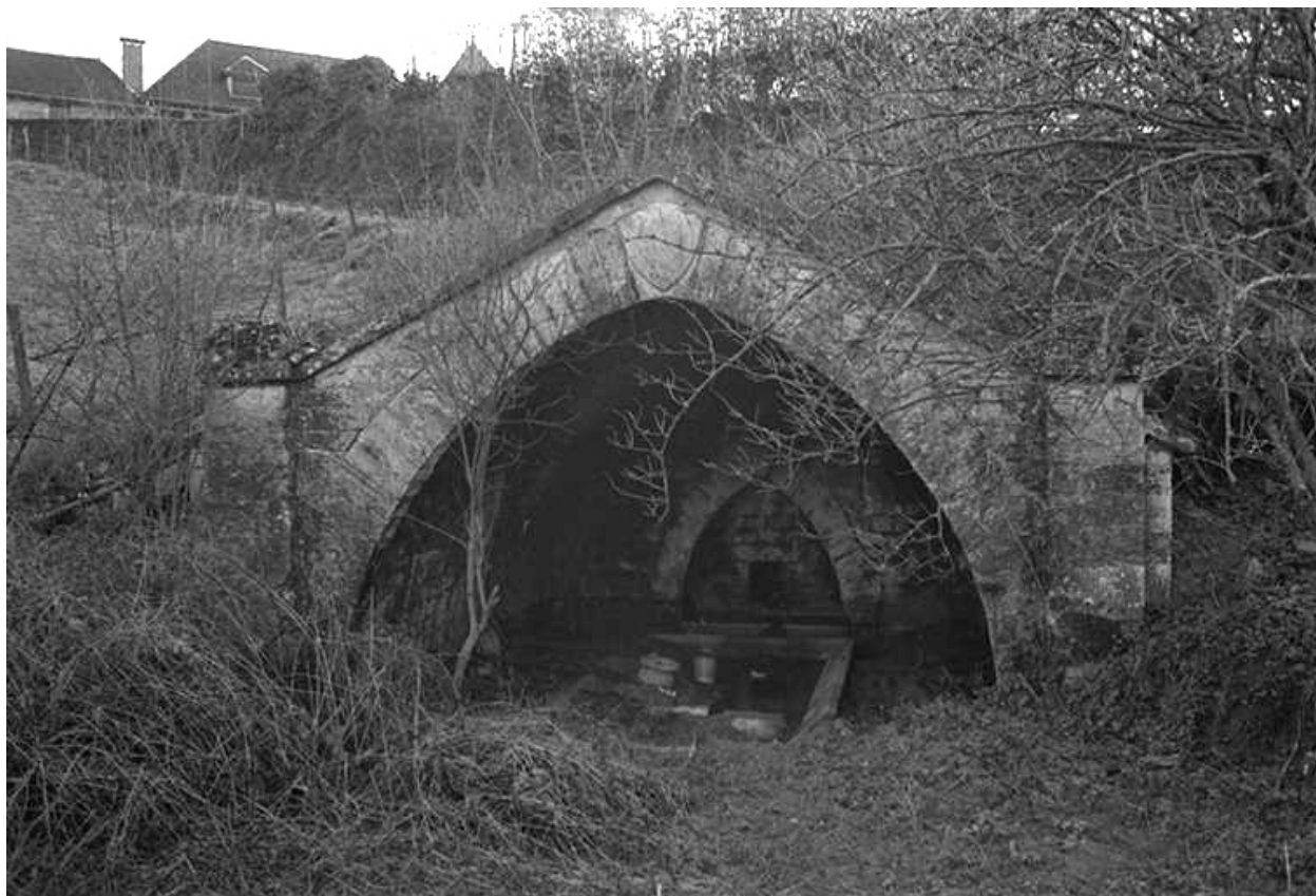
Lavoir situé chemin de la Massette.
