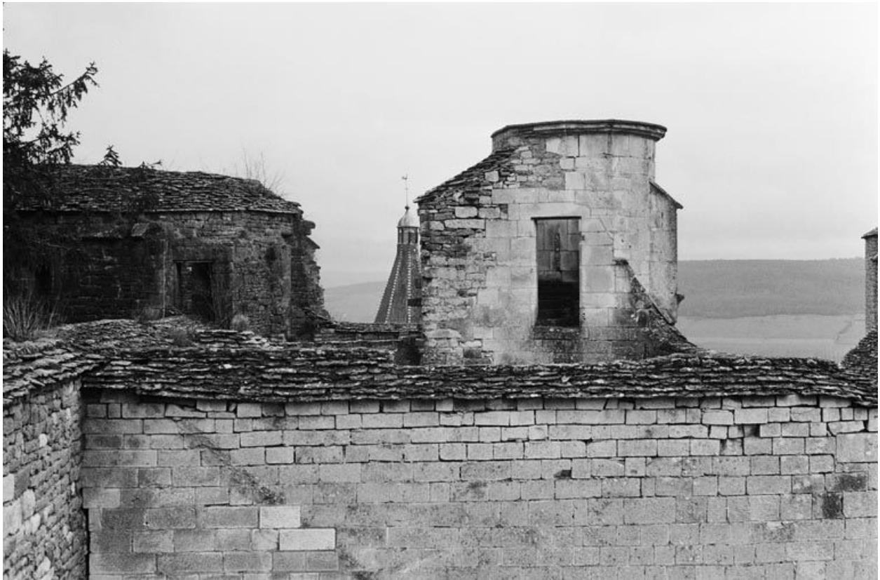
Tourelle du logis des Hôtes : vue latérale (photo prise en 1969).
