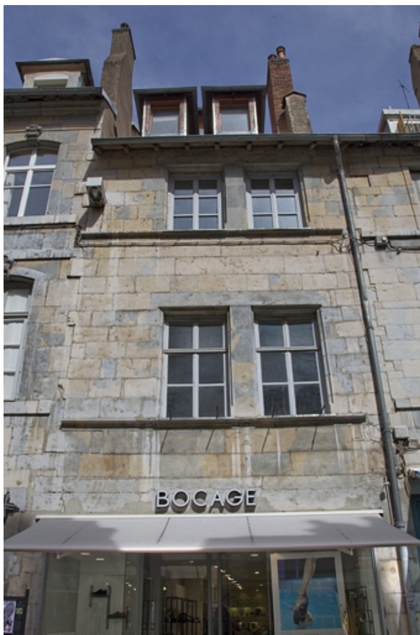
Logis principal, façade sur rue : de face.
