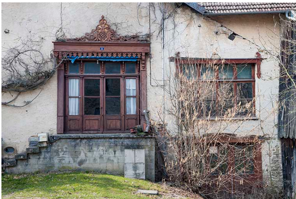
Façade sud. Entrées des ateliers.
