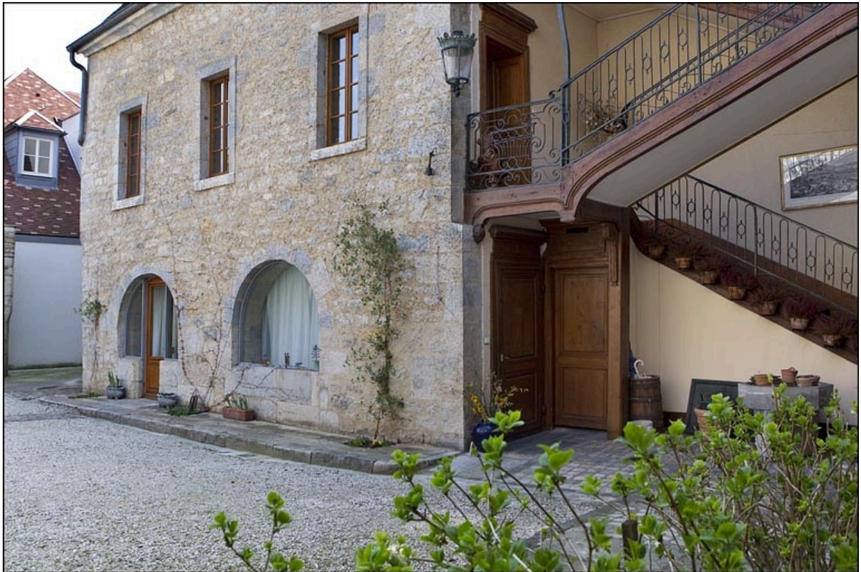
Vue d'ensemble du bâtiment des cuisines, de trois quarts droit.
