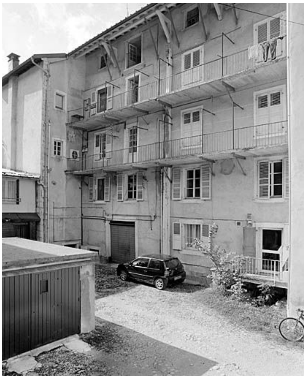
Façade postérieure du n° 143.
