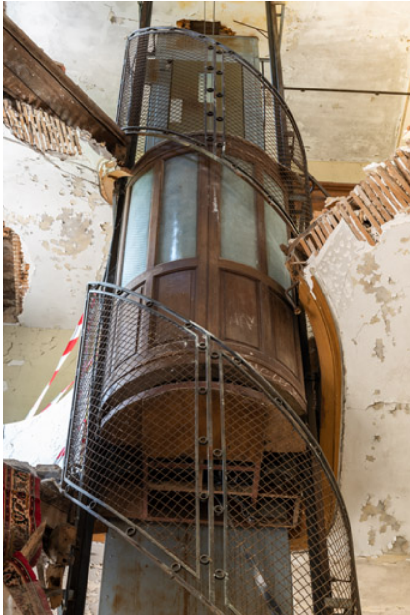
Ascenseur de l'escalier ouest, cabine.
