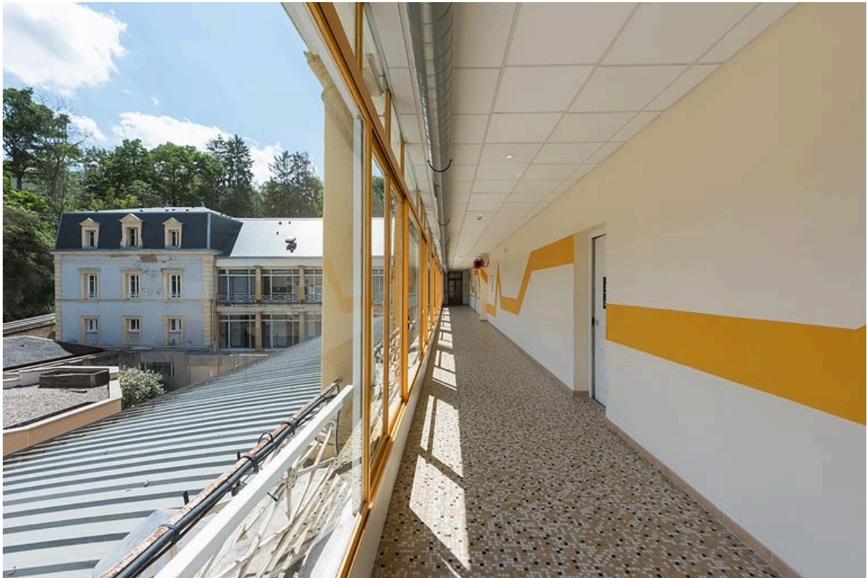
Galleries du deuxième étage.
