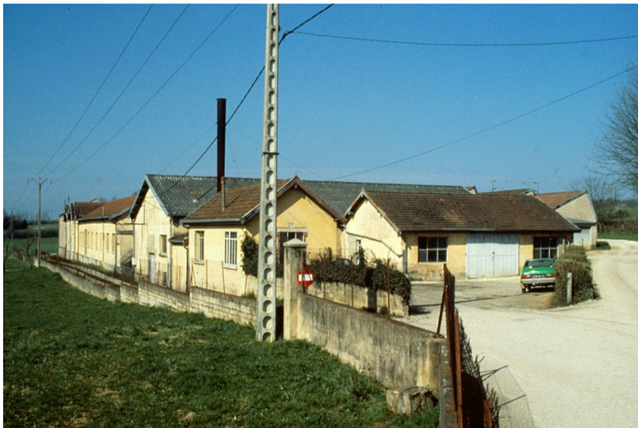
Entrée de l'usine.
